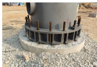
图 1 设备安装后 发现基础标高不符合
