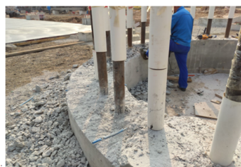
图 2 设备基础 标高不符合
