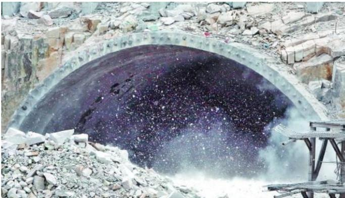
图1 爆破施工飞石情况
