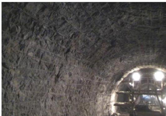
图4 光面爆破现场效果图
