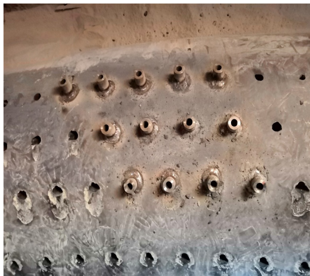
图4 焊接短管后图片
