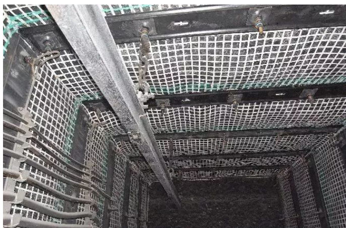
图1 顶板安全管理定期检查
