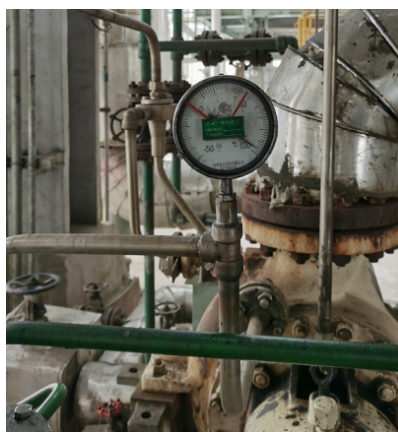
图 2 密封系统温度高
