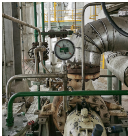
图10 密封系统温度正常(检修后)
