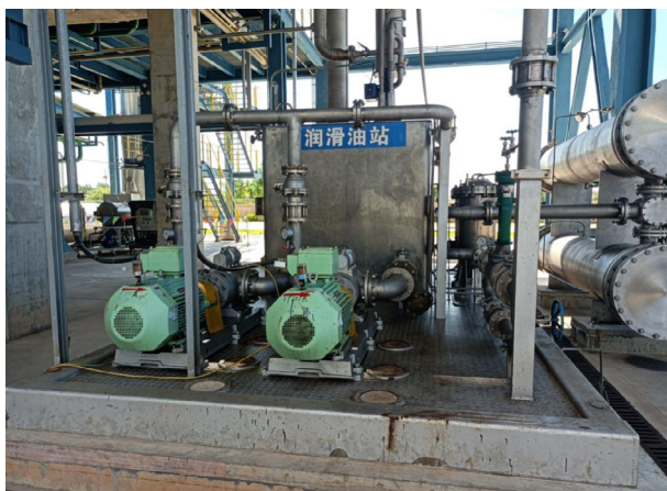
图2 典型的撬装设施配置之二 --- 润滑油站
