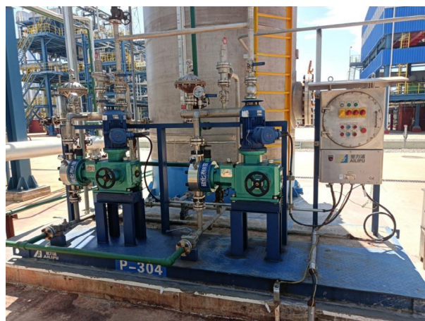
图1 典型的撬装设施配置之一——加药装置
