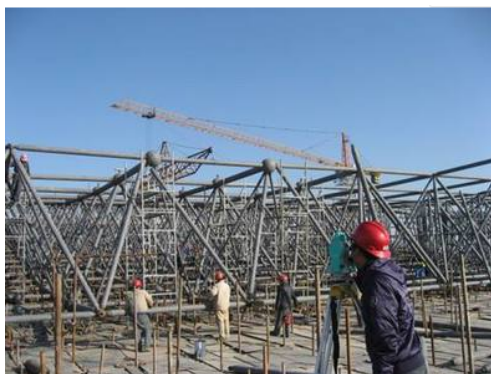
图1 钢网架地面施工现场图
