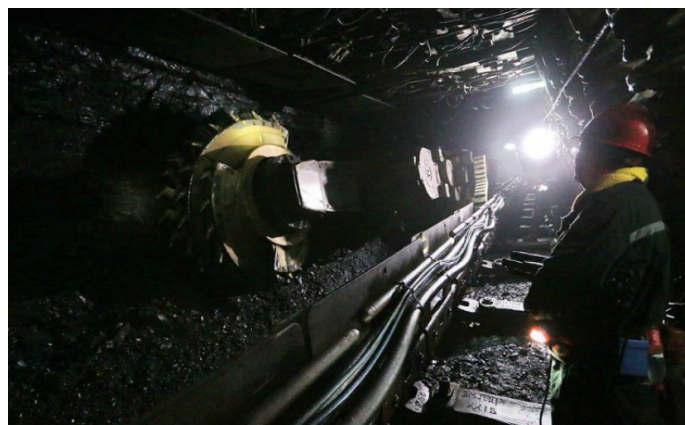
图2 井下复杂的电缆敷设图
