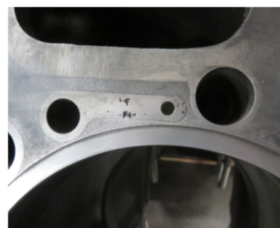
图 3 缸体密封面的气蚀坑
