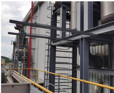
图11 改造后的水箱排气管
