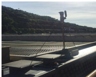
图10 改造前的水箱排气阀
