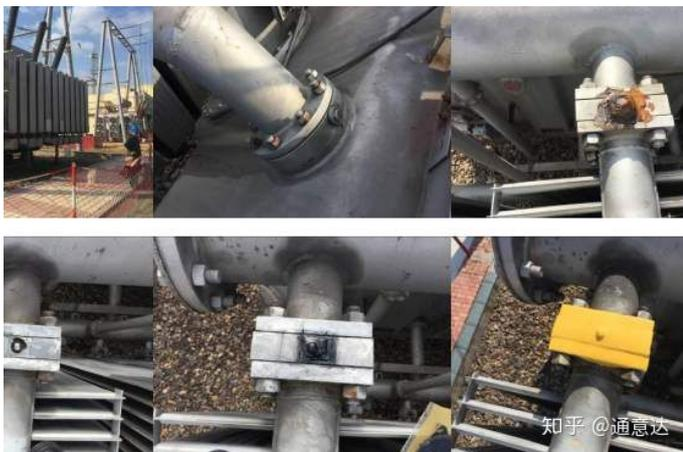
图1 变压器渗油位置
