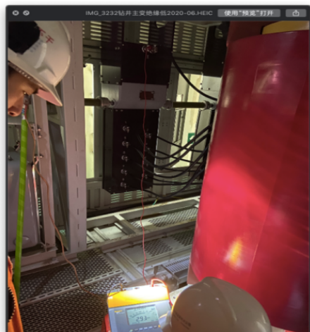
图 1 测量绝缘
