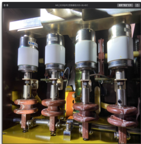
图 2 调压器内部结构
