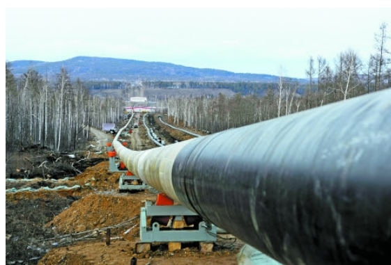
图2 在无人区铺设的架空管道
