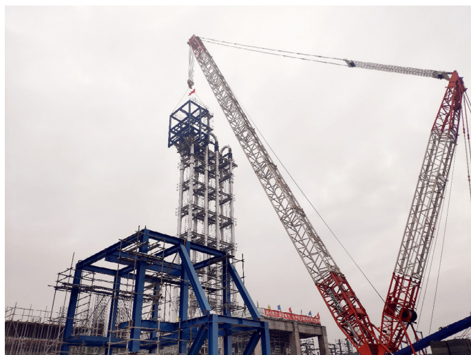
图2 为二反主体框架吊装
