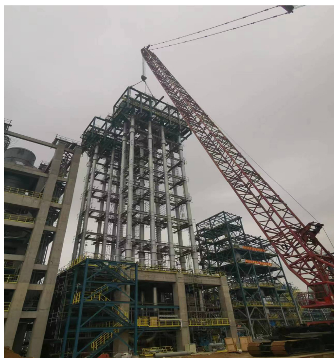
图1 为一反模块化吊装
