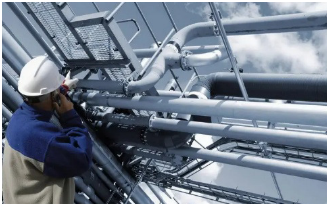
图1 石油化工管道安装
