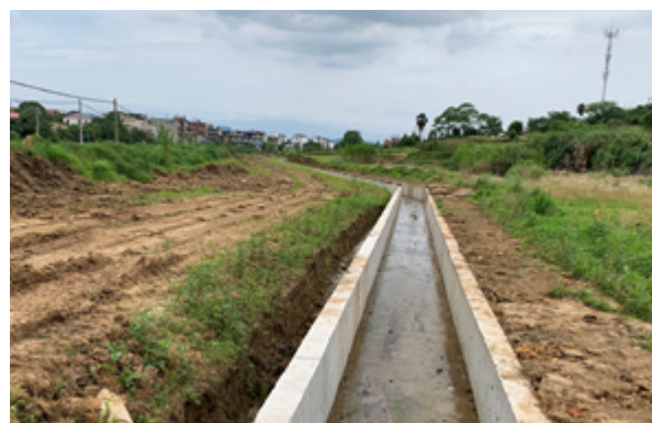
图3 混凝土导流沟实景图
