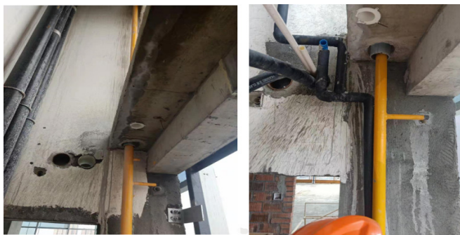
图2 某超高层建筑室内燃气管道现场安装图
