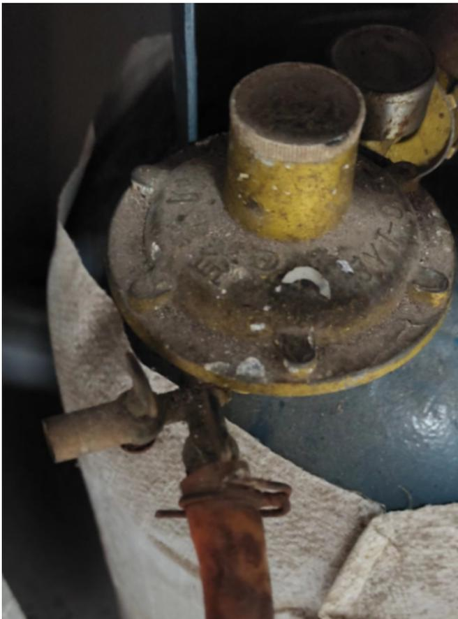
图1 LPG用户端不符合标准的调压器、软管，以及连接方式
