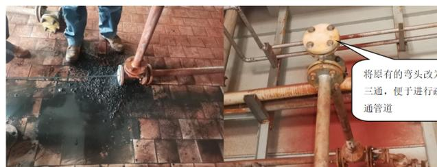
图3 钢衬四氟管道堵塞,改造后进行疏通
