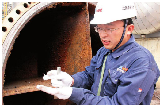
图1 防腐检查现场
