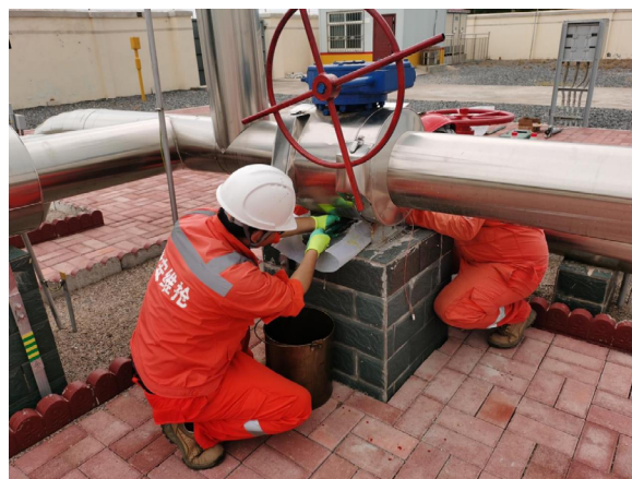
图1 现场人员进行风险监控
