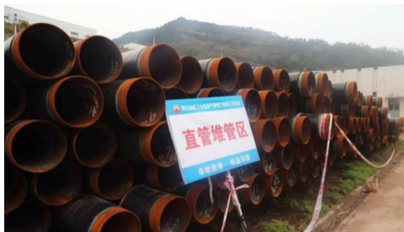
图1 施工材料分类码放、显著区分
