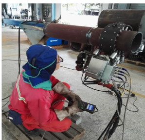
图5 大口径 dn300 管的焊接
