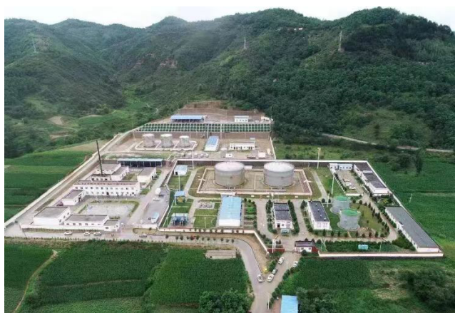
图2 带储油罐的中间输油场站
