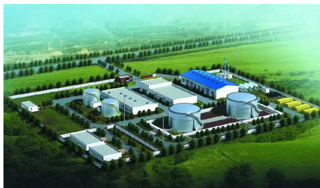
图 1 带储罐的中间输油场站布置
