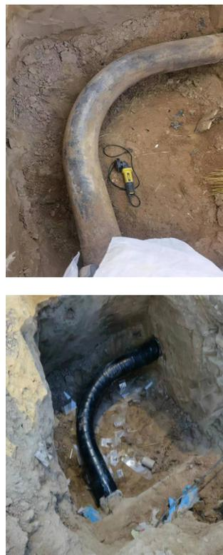
图1 纤维复合材料修复前后对比图
