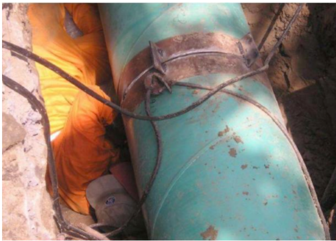
图2 燃气管道焊接现场
