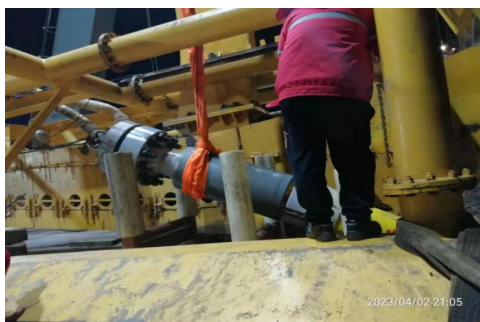
图 1 柔性复合软管架设
