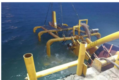
图 3 柔性复合软管铺设
