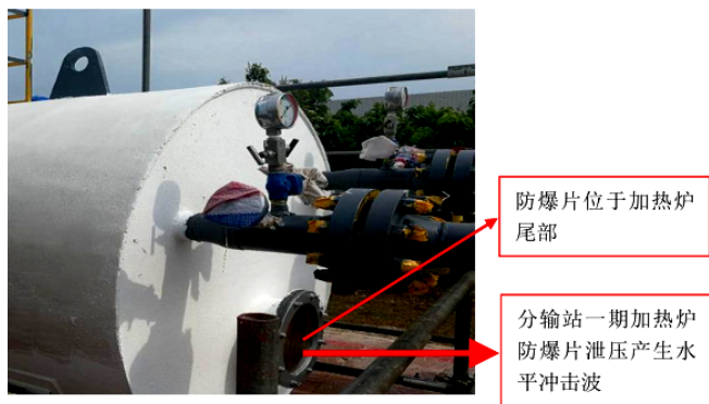
图1 一期加热炉防爆片式防爆门结构图
