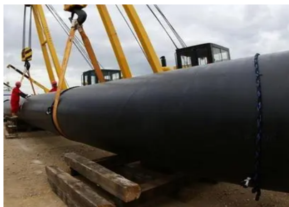
图 1 管道吊装以及道木垫层示意图
