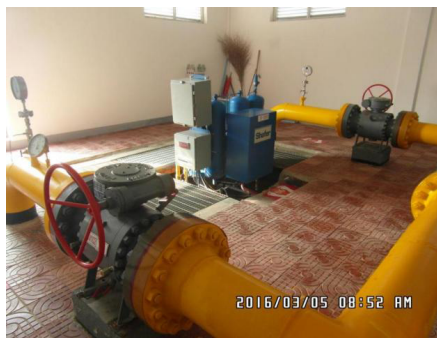
图 1 截断阀安装图
