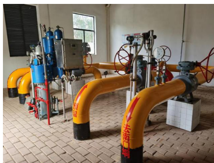
图 2 截断阀安装图
