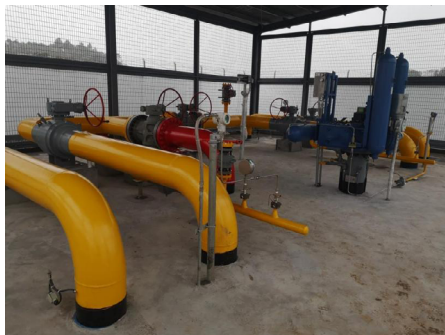
图3 截断阀安装图
