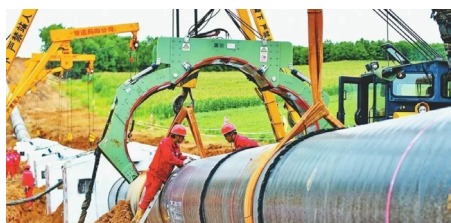
图1 天然气管道完整性管理与管道腐蚀检测技术现场图
