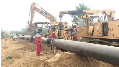
图 2 天然气长输管道对接现场
