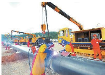
图 3 天然气长输管道焊接
