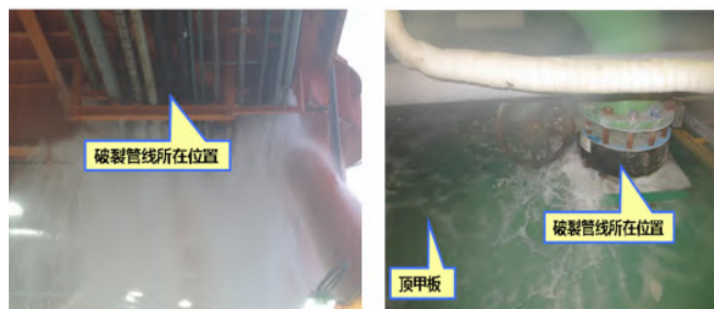
图 1 玻璃钢管道泄露现场照片
