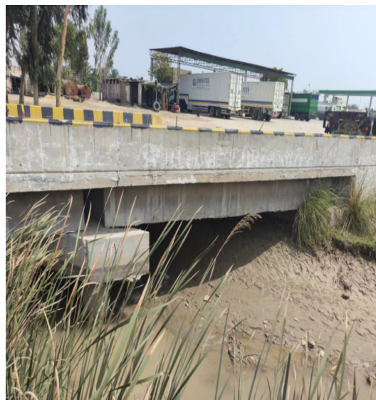
图 1 高温环境下道路重建现场图
