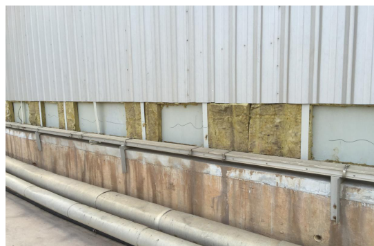
图 5 罐外局部保温处理
