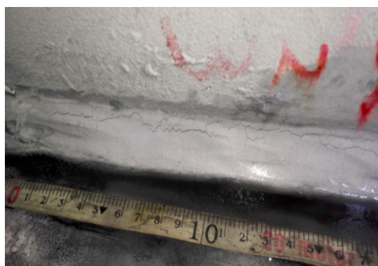
图2 裂纹长度22cm
